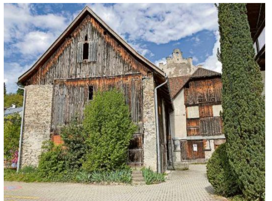
Raum für Neues: Die Umbauarbeiten am Ökonomiegebäude auf dem Türligartenareal sollen bis 2024 abgeschlossen sein.
