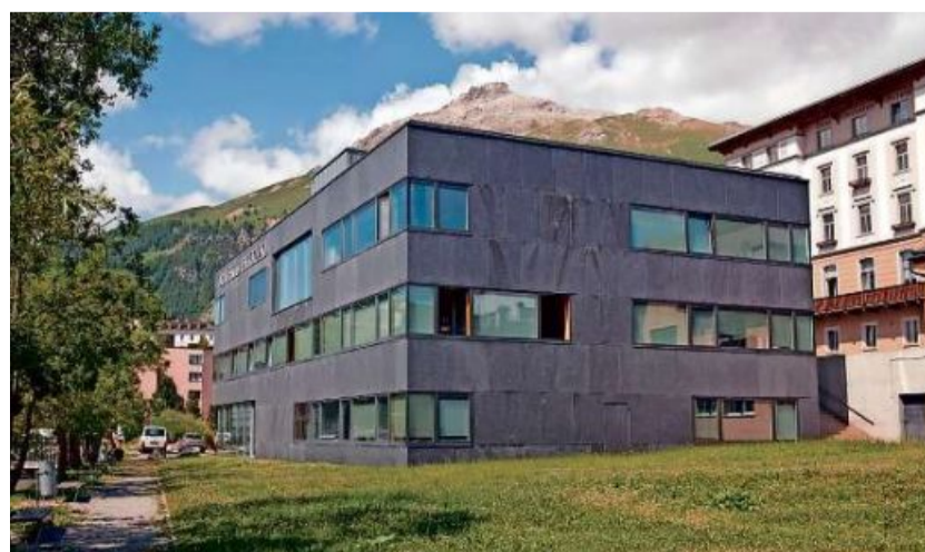
Verschiedene Schäden: Die «Chesa Naira» in Samedan muss für 2,2 Millionen Franken saniert werden.
